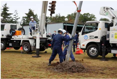
【各社協力による建柱作業】
